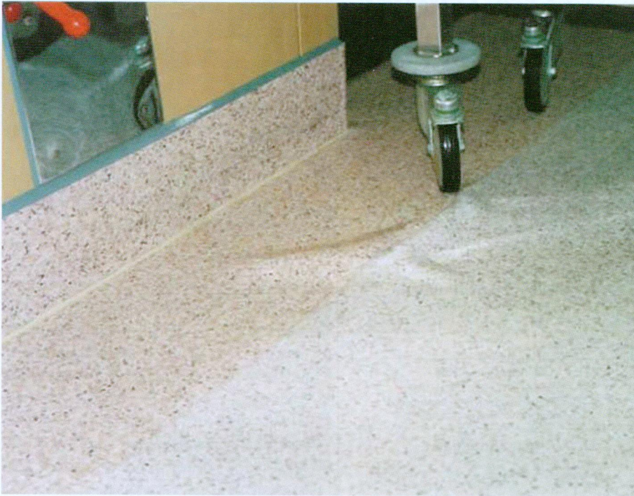
Typische Feuchtigkeitsbeulen in einer PVC-Bodenbelagebene.
