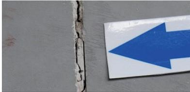
•Partielle Aufwölbungen/Verformungen der Betonbodenplatte von den jeweiligen Scheinfugen ausgehend.
