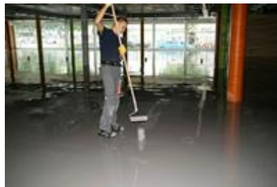
Auftrag der Beschichtung
