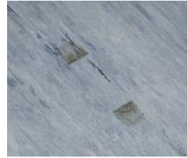
Verfärbung und Eindrücke durch ungeeignete Rollen
