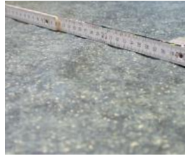
Zerstörung durch harte Rollen
