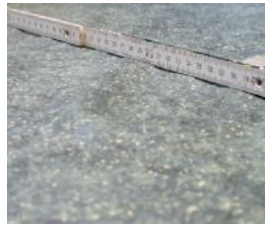
Zerstörung durch harte Rollen
