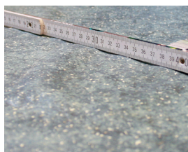
Zerstörung durch harte Rollen
