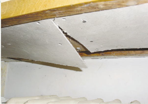
Asbesthaltige Leichtbauplatte
