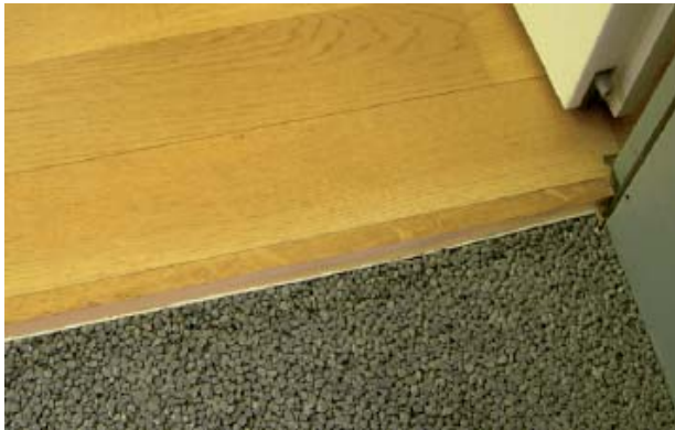
Uebergang bei Belagswechsel mit Schlütterschiene
