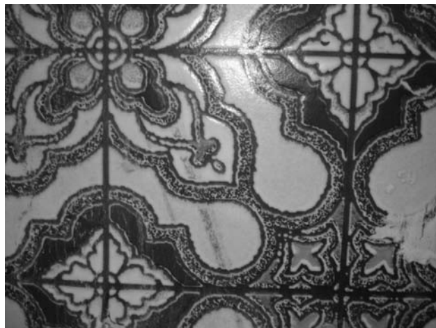
Dreischichtiger Bodenbelag mit Asbestpappe, Foto: Carbotech AG
