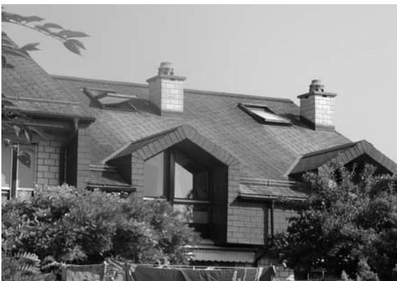
Dachschiefer aus Asbestzement, Foto IST
