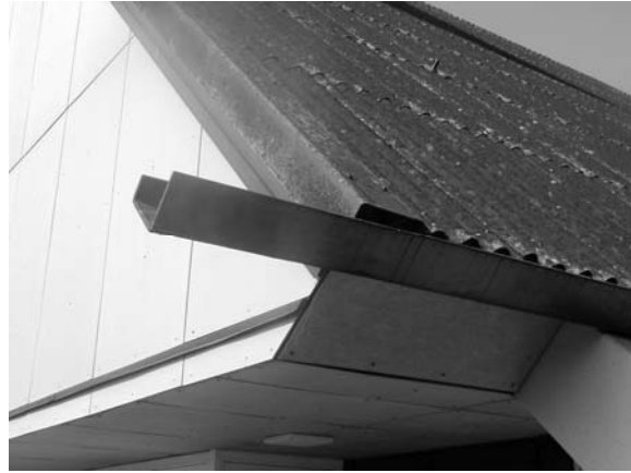
Asbestzement-Wellplatten, Foto IST
