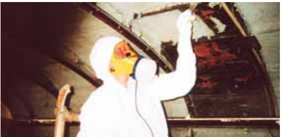
Asbestsanierung
