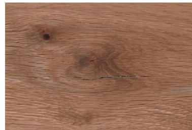
RISSE Längstrennung der Holzfasern, die nicht durch den ganzen Querschnitt geht. Die Risse entstehen durch Spannungen bei der Holz Trocknung.
