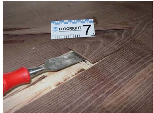
Leichte Ablösung der Decklamellen (Mangelhafte Verbindung).
