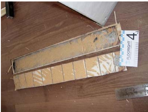
Hohlklingende Riemen trotz einer perfekten Verklebung (Decklamellen).
