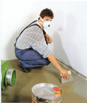
Bild 3: Die Atemschutzmaske mit Aktivkohlefilter verhindert das Eindringen von Lösemitteldämpfen in die Atemwege. Sie ist dort zu tragen, wo die Absaugung ungenügend ist.
