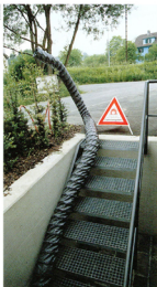
Bild 4: Gefahrenzone. Wandreißung und Abspernung, hier beim Ausheben der Lösemitteldämpfe ins Freie. Auf die gleiche Weise muss der Arbeitsbereich abgesperrt und signalisiert werden.
