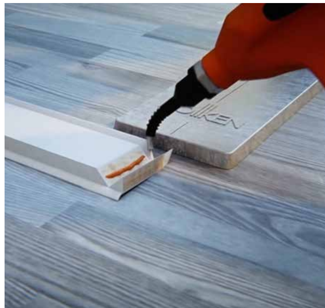
Schmelzkleber auftragen
