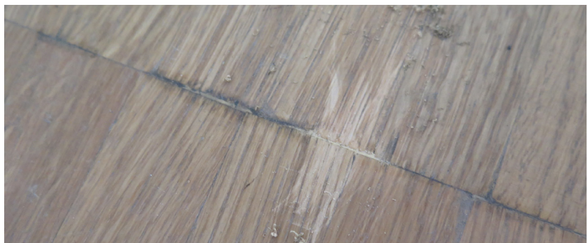
Entfernen der Verschmutzung durch Abschaben, darunter Holz ohne Verfärbung
