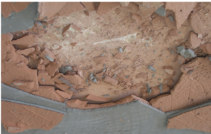
Der DDR-Anhydrit wurde durch die Trocknungsspannungen der neu aufgetragenen zementären Spachtelmasse regelrecht zerrissen
