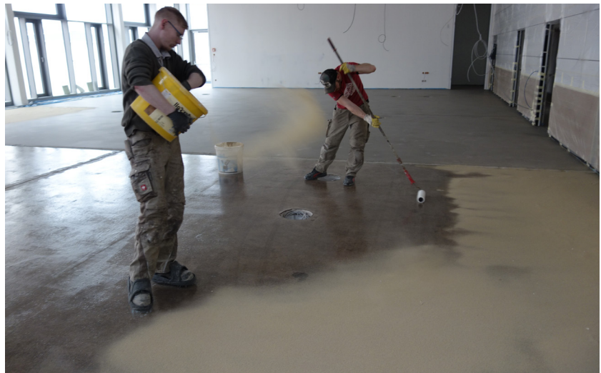
Die Stahlbetondecke wurde mit einer abgequarzten Reaktionsharzgrundierung abgesperrt
