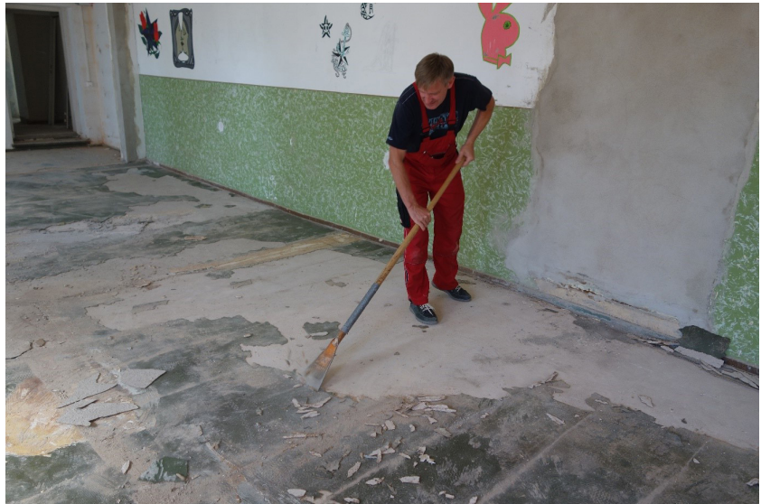
Die abgeplatzte Spachtelmasse wurde mit einem Schaber restlos entfernt
