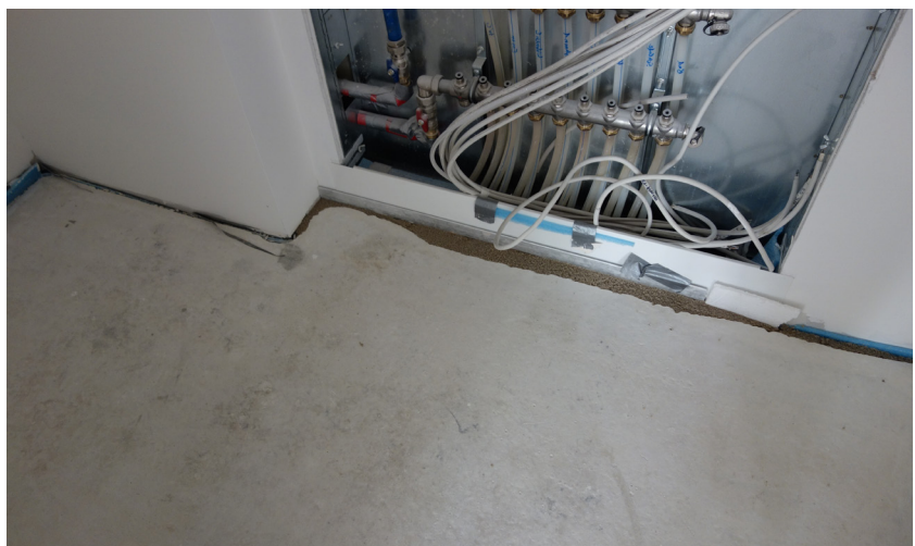
Hohlräume zwischen Estrich und Randstreifen wurden mit Epoxidharzmörtel geschlossen
