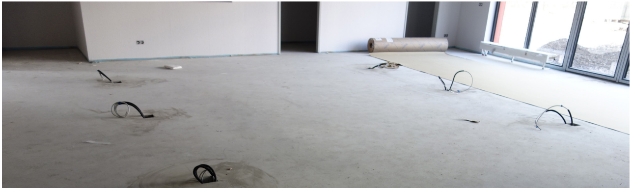
Calciumsulfatfliessestrich fugenlos in einer grossen Produktionshalle, Bilder: Wolfram Steinhäuser
