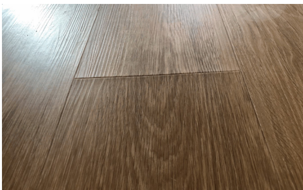
Beispiele von Stippnaht und offener Fuge aufgrund von falscher Akklimatisation
