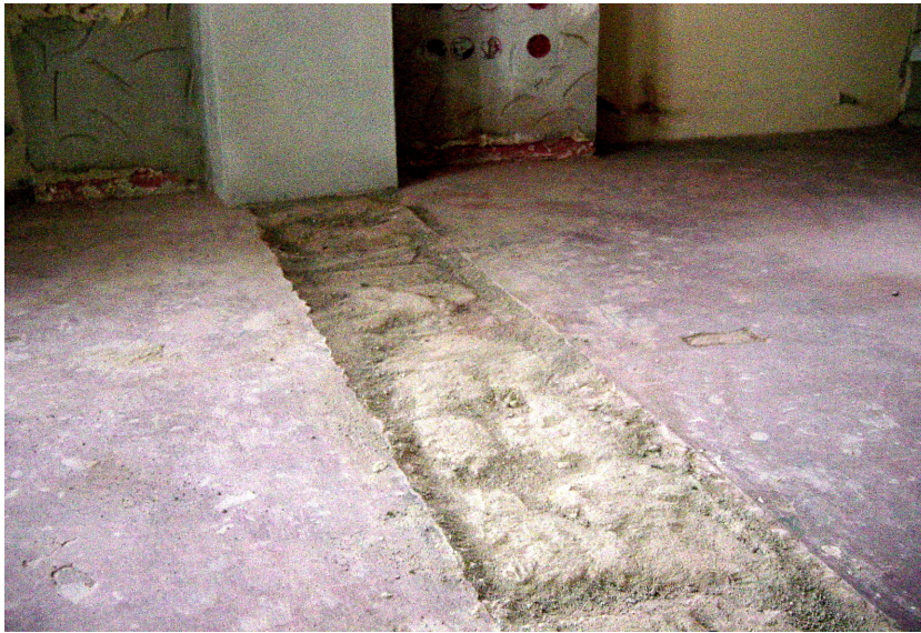
Fehlstellen im Altestrich werden i.d.R. mit einem Schnellestrich geschlossen
