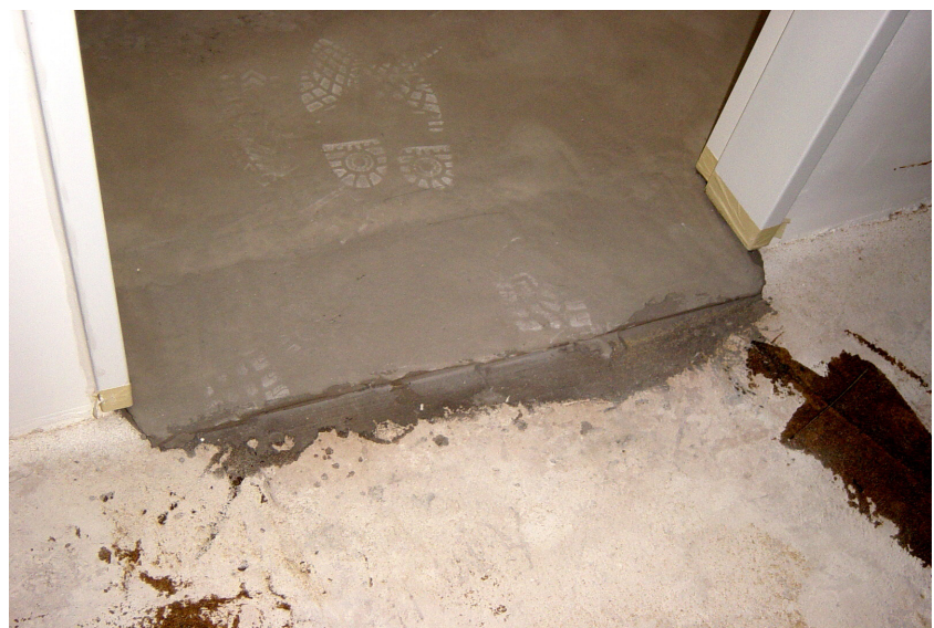
Die Fehlstelle im Türbereich wurde mit einem Schnellestrich geschlossen
