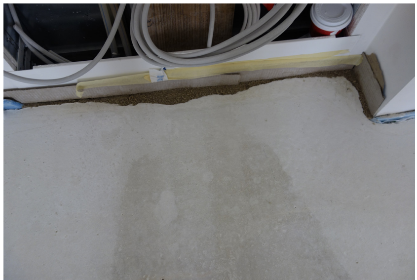
Fachgerecht geschlossene Fehlstelle im Randbereich mit einem Reaktionsharzmörtel
