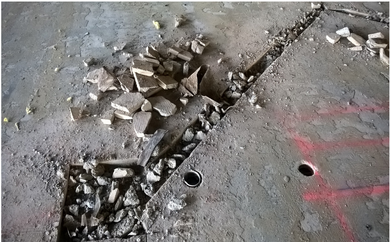
Diese Ausbrüche werden i.d.R. mit einem Schnellestrich geschlossen, Bilder: Wolfram Steinhäuser
