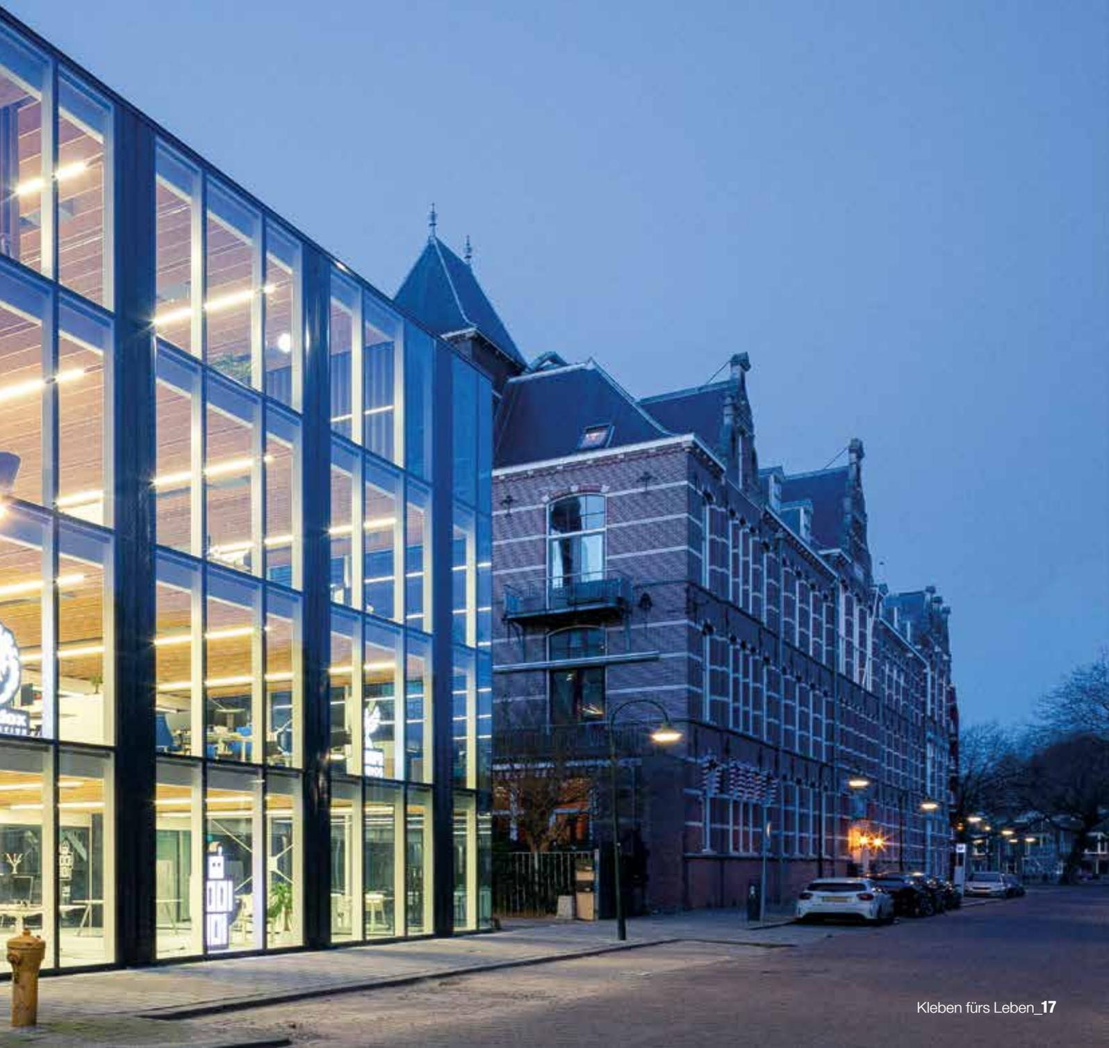
**Das Gebäude (D)emountable in der niederländischen Stadt Delft ist ein viergeschossiger Bürokomplex, der in kurzer Zeit vollständig zerlegt und an einem anderen Ort wieder aufgebaut werden kann - ein absolutes Vorzeigeprojekt in puncto innovative und nachhaltige Bauweisen. Zu den Hauptbestandteilen des modernen Gebäudes gehören Holzelemente, die zum einen superleicht und zum anderen außergewöhnlich fest, belastbar und formstabil sind - Klebstoff macht's möglich.**
