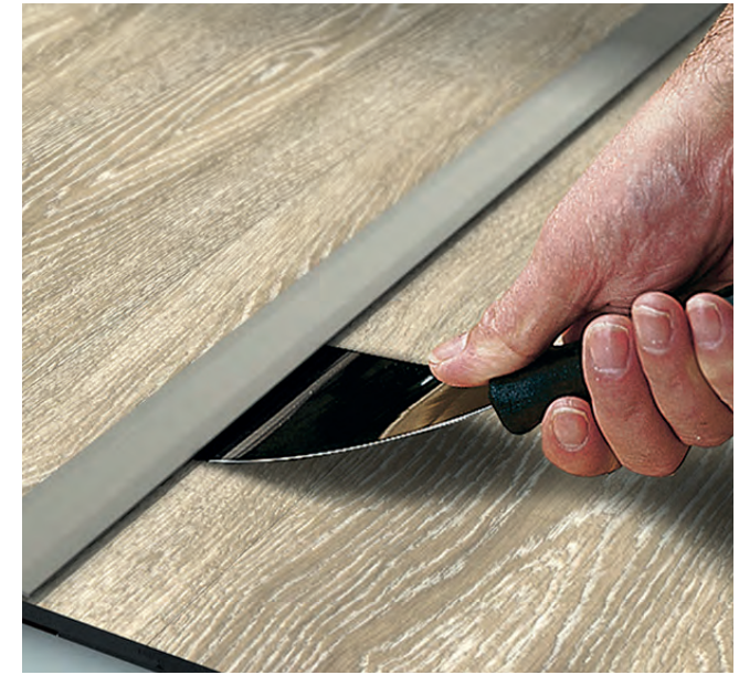
Demontieren, Abb.: Prinz Profi Design Nr. 322
