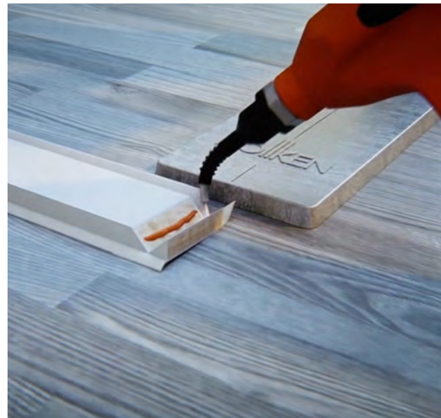
Schmelzkleber auftragen
