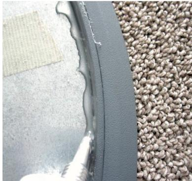
Nach dem Aufbringen des transparenten Nahtkantenverfestigungsmittels wird der passgenau geschnittene Teppichboden gegen den Klarsichtleim geschoben, so dass dieser sich im Schnittkantenbereich nach oben drückt.
