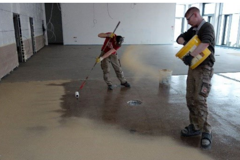
Die Stahlbetondecke wurde mit einer abgequarzten Reaktionsharzgrundierung abgesperrt
