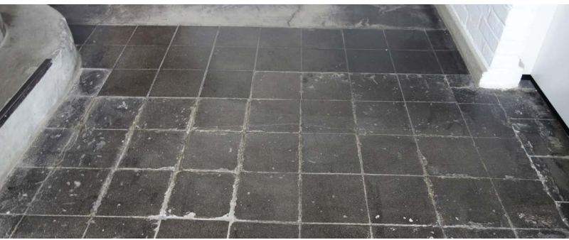
Stampfasphaltplatten in der Toilette des Bauhausmuseum Dessau
