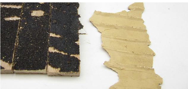
L'arrière des lames de parquet est recouvert de la chape d'asphalte instable
