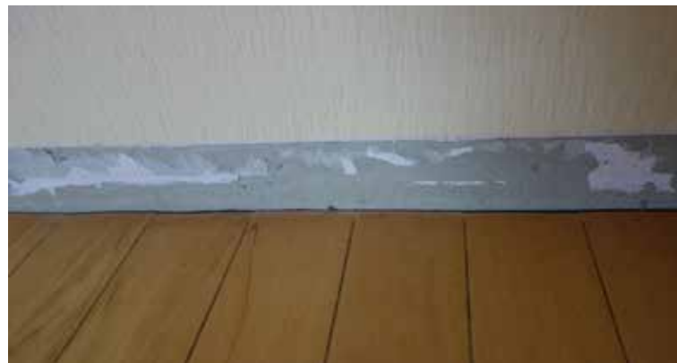
Der Putzgrund für die Montage der Sockelleisten muss fachgerecht vorbereitet sein
