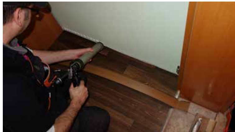
Auftragen eines lösemittelfreien Montageklebers
