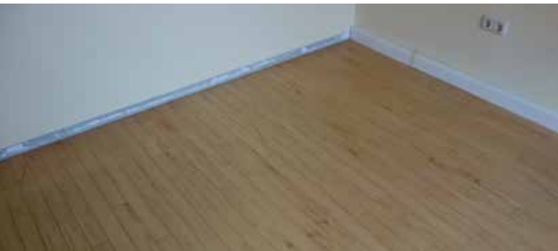
Die alte PVC-Sockelleiste wurde entfernt
