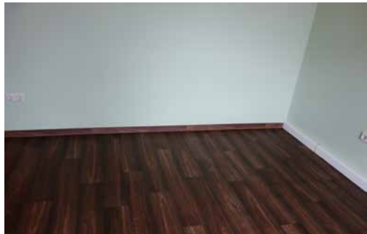
Fertiggestellte Sockelleiste passend zum neuen CV-Belag
