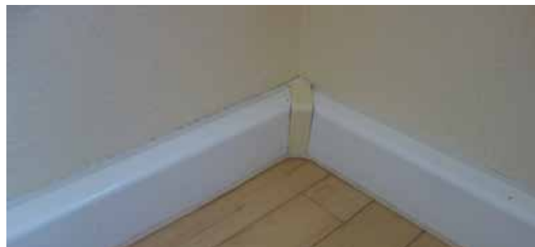
Fachgerecht eingebaute Sockelleiste für Heizungsrohre im Eckbereich
