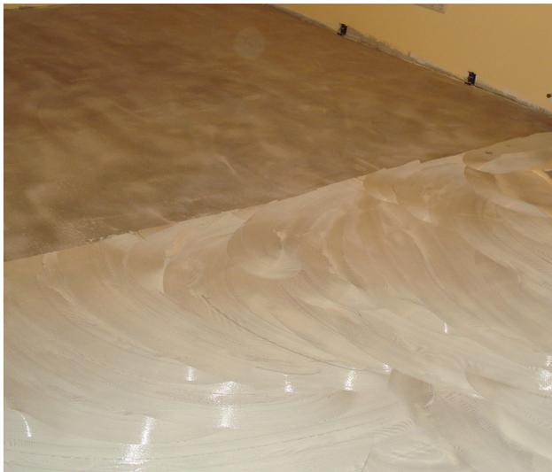
Dispersionsklebstoffe sind auf saugfähigen Untergründen so lange ablüften zu lassen, bis die halbnasse Phase des Klebstoffes (Tackklebung) erreicht ist.
