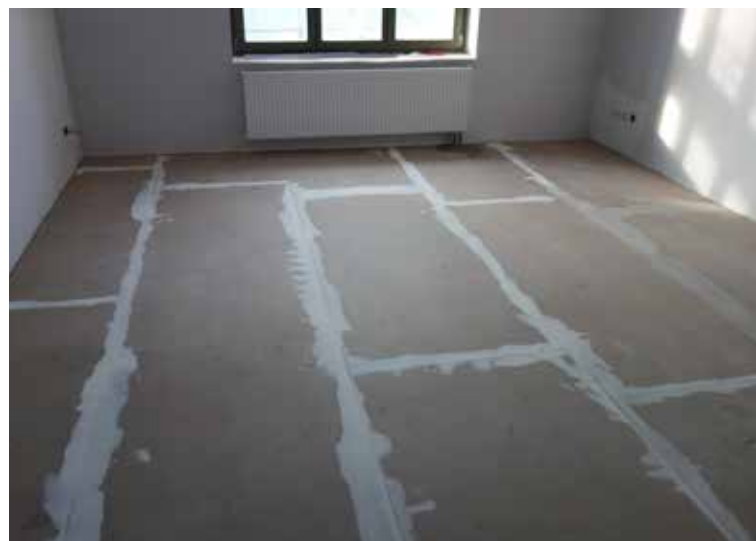
Chape sèche posée dans les règles de l'art
