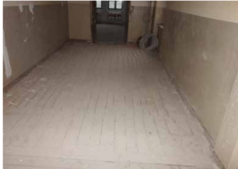
Des chapes sèches sont souvent posées sur d'anciens planchers
