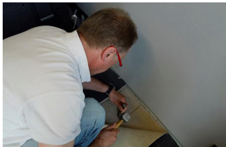
Probenahme aus dem Estrich
